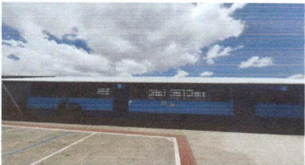
Foto 4: Módulos de aulas 3 y 4: desinstalación de lámina existente; sustitución de lámina por lámina troquelada aluzinc calibre 26 e instalación de canales.
