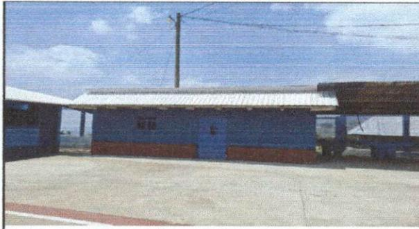
Foto 3: desinstalación de lámina existente; sustitución de lámina por lámina troquelada aluzinc calibre 26 e instalación de canales.-
